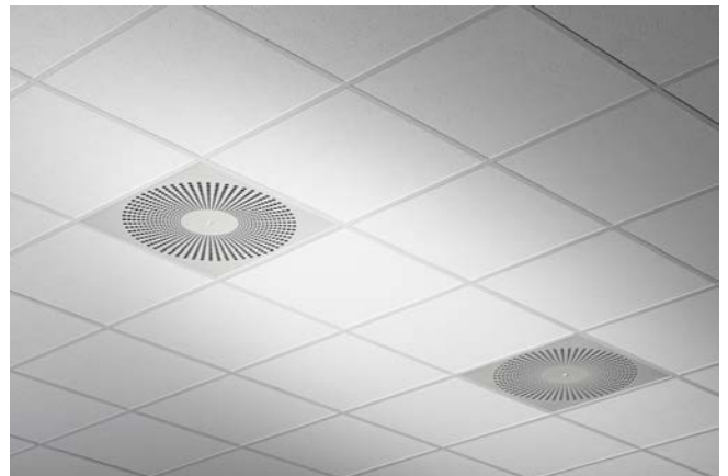
Einbau in T-Profil-Decken, Reihenanzordnung
