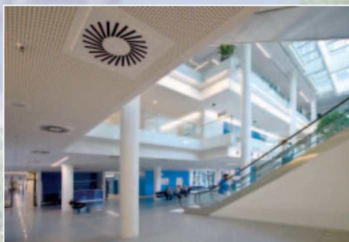
Dralldurchlässe der Serie VDW im Universitätsklinikum Hamburg-Eppendorf (Deutschland)
