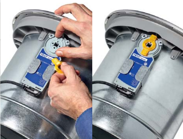
Selbstadaptierender Antrieb mit voreinstellbarem Schwenkwinkel
